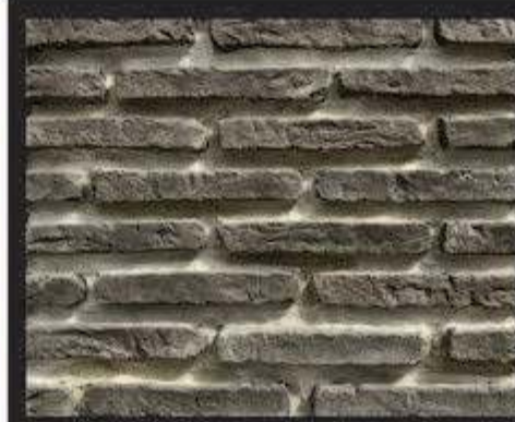
Osmanlı Tuğlası Dike - 2607
