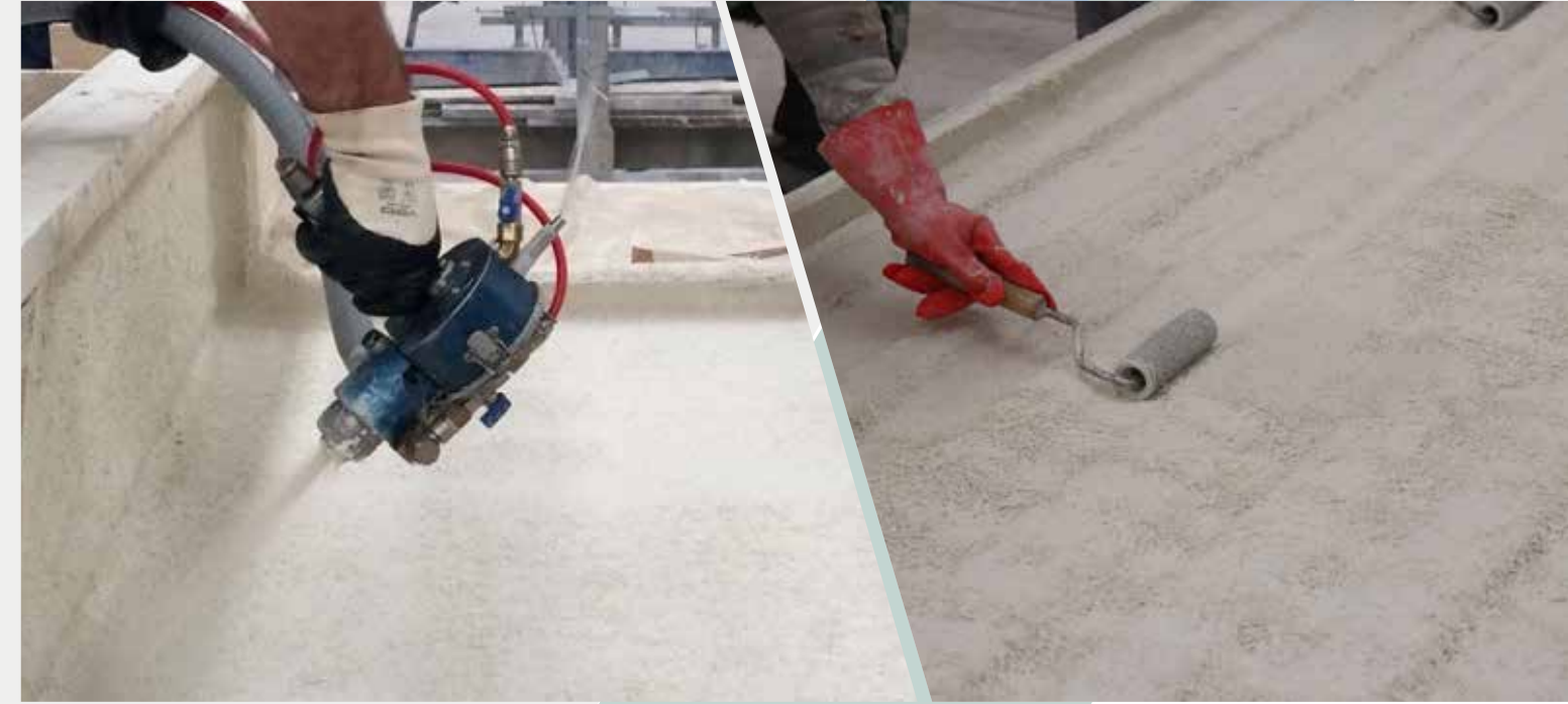
Resim. Buğu tabakası, püskürtme döküm işlemi ve rulolama ile sıkıştırma.
