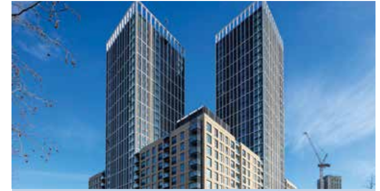
FİROCEPHE® / FİROPANEL® ALÜMİNYUM CEPHE PANELİ ÜZERİ MONTAJ UYGULAMALARI
